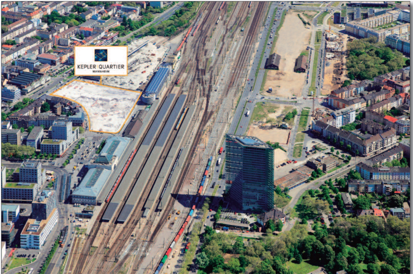
Hinter dem Kepler Quartier liegt das Eyemaxx-Areal, rechts von den Schienen das Glückstein-Quartier
