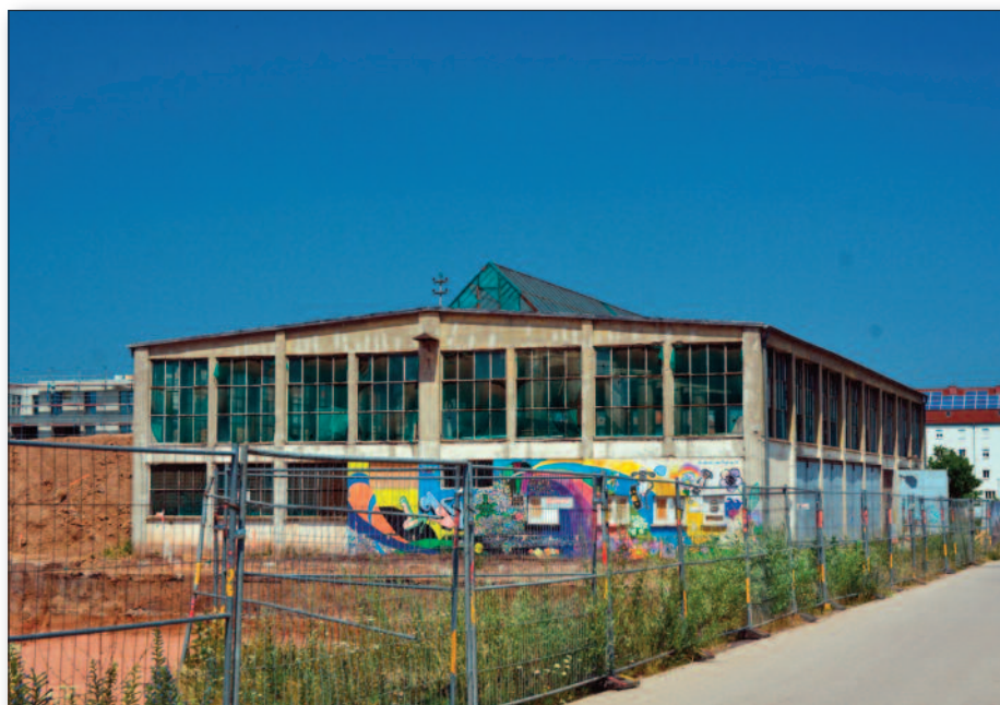
Den gegenwärtige Zustand der ehemaligen Panzerhalle kann man als leicht marode, aber äußerst farbenfroh bezeichnen
