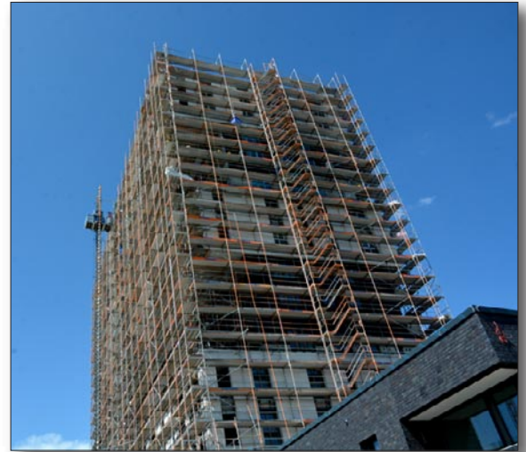
Noch ist der Hochpunkt E komplett eingerüstet
