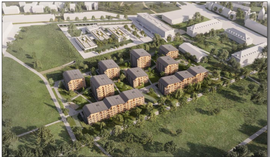
Baustart für das Wohnquartier am Buga-Park auf Spinelli
