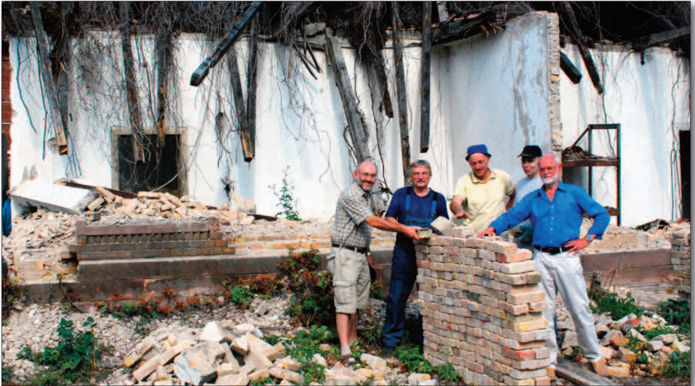
Stein für Stein wurde die alte Schienenfahrzeughalle im Herbst 2012 von den Mitgliedern einer Bürgerinitiative abgebaut und eingelagert, damit sie jetzt wieder entstehen kann
