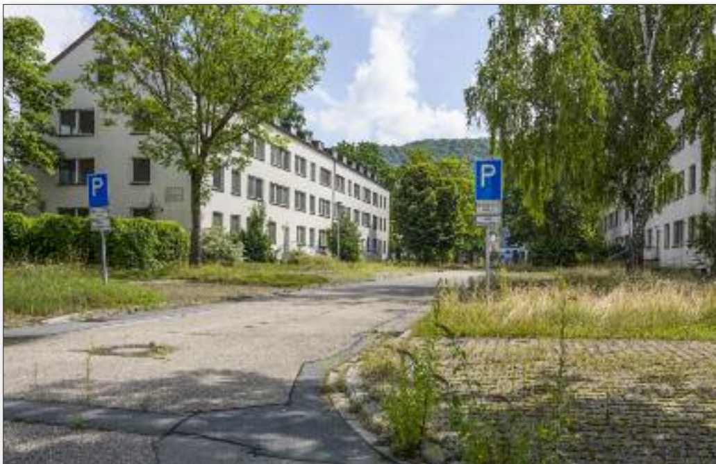
Die MTV investiert rund 320 Millionen Euro in Neubau und Sanierung von etwa 1.300 Wohnungen.
